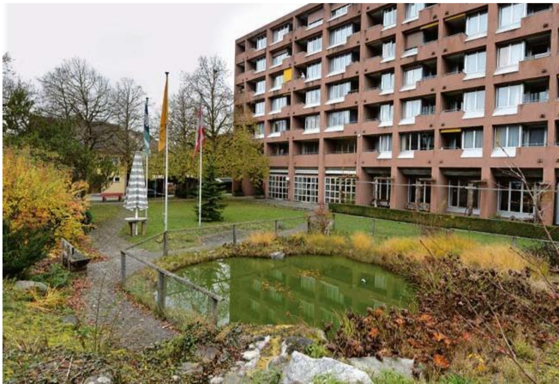
6 Millionen Franken will Thayngen 2015 für die Sanierung des Alterswohnheims ausgeben.
